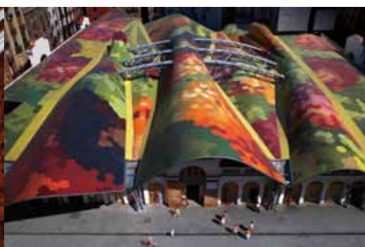
Marché Santa Caterina, rénové par l'architecte Enric Miralles
